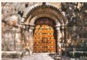
Façade tardorromanica, église de Hoyos
