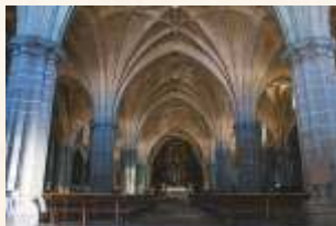
Sta. María de Rocamador (Valencia de A.)
