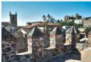
Vue depuis la tour de Bujaco
