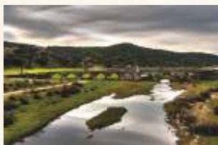
Ponte sobre o rio Almonte
