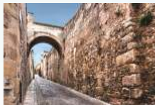
Muralha na rua Adarve de la Estrella
