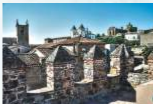
Vista da torre de Bujaco
