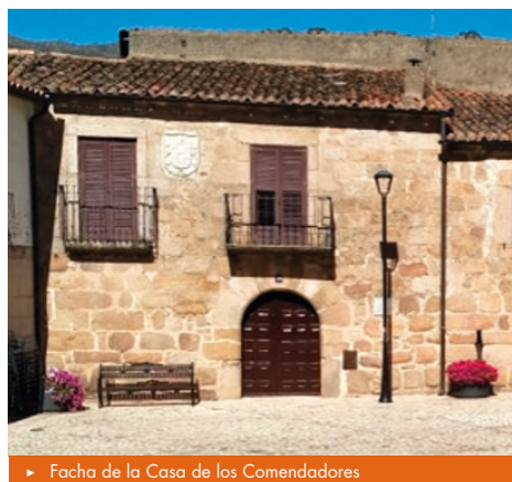
► Fachada de la Casa de los Comendadores
